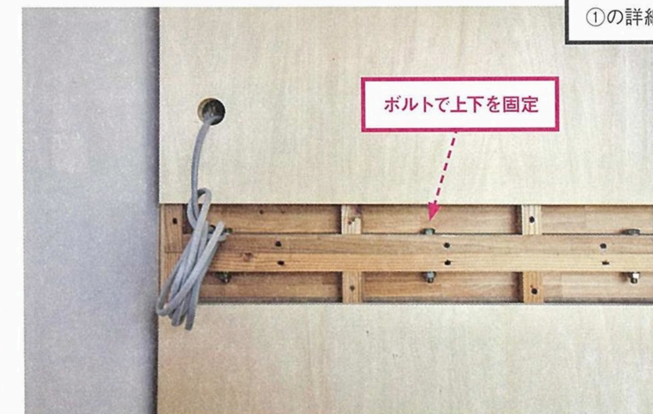
上下の連結部の納まり。ずれないようにボルトで連結
