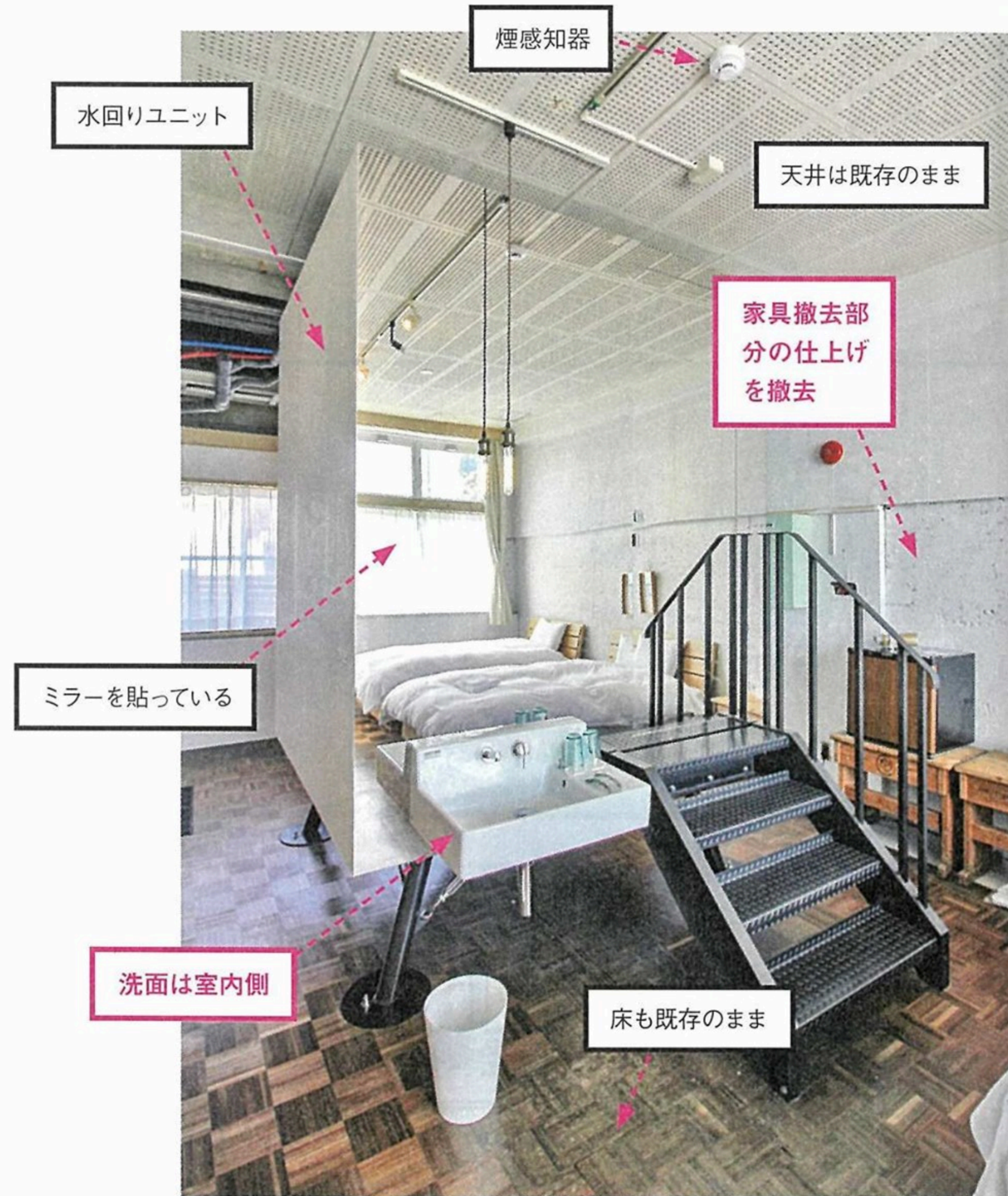
個室タイプの客室には箱型の水回りユニットを設置
