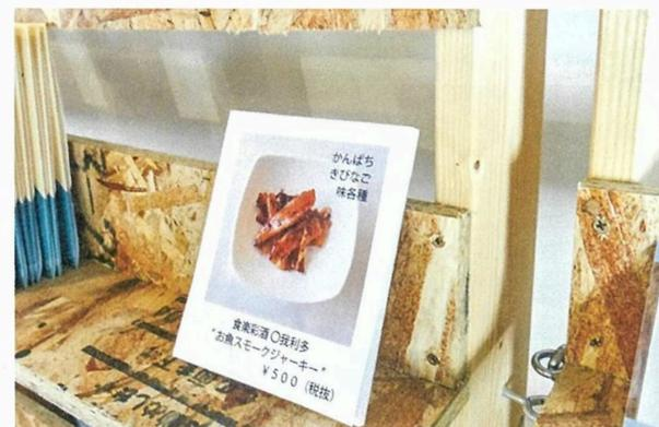
什器の詳細。L型に組んだ棚板を支持するツーバイ材にビスで固定
